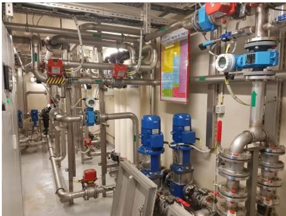
Slika 8: Črpalni blok UF pitne vode Jelovec
